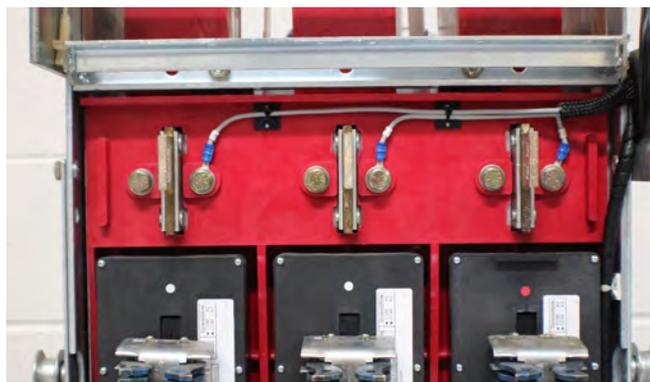
Conexões de tensão ao lado da linha no disjuntor DS (conectores de cobre removidos)
